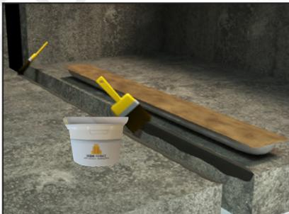
Encole los dos lados de la junta sobre 100 mm de altura así como un ancho de 5 cm en la parte superior del hormigón, con la cola VEDACOLLE<sup>®</sup>.
