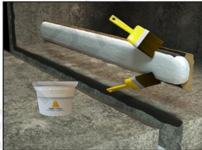
Encole la parte de abajo de las aletas así como la parte vertical de la capa, sobre una anchura de 6 cm.
